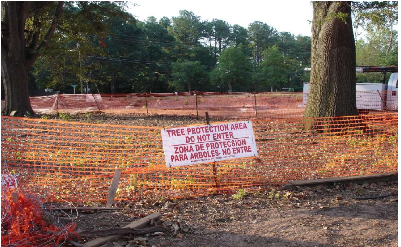
Esempio di protezione alberature in area di cantiere ( https://www.ncufc.org/tree-protection-during-construction.php )
