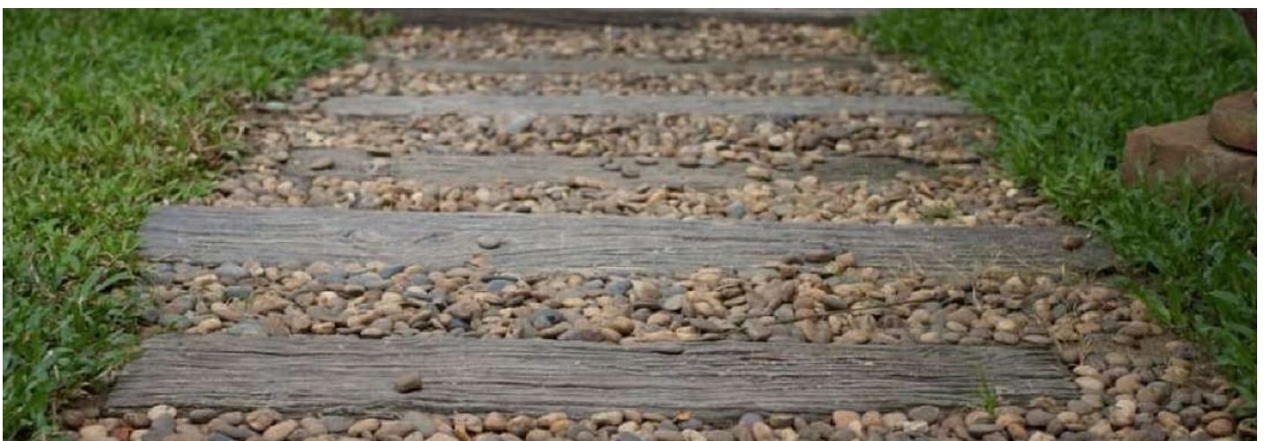
Sentiero in legno e ghiaia (si utilizzi legno trattato o da esterno)
