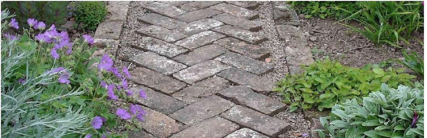
Pavimentazione in mattoni
