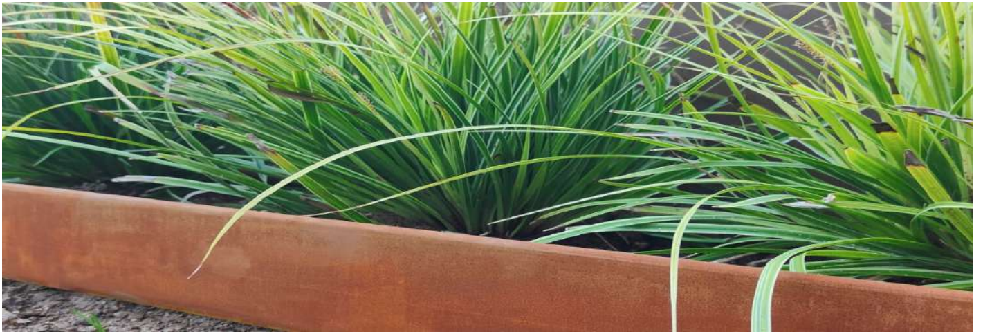
Bordo di contenimento in acciaio cor-ten
