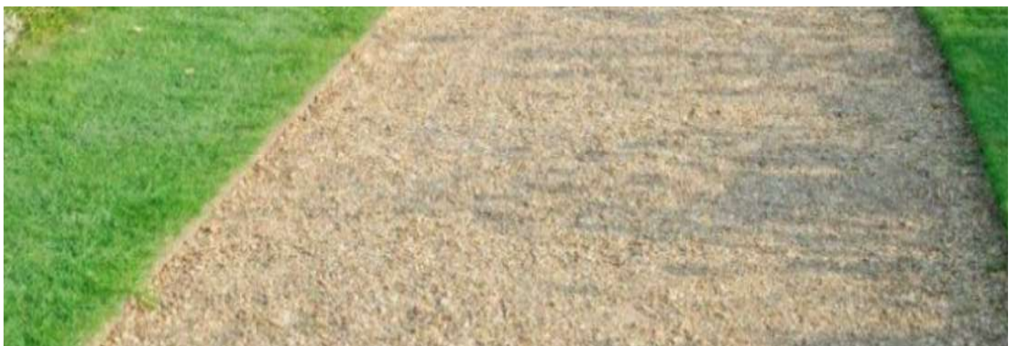
Percorso in calcestre o in ghiaia con sottofondo in stabilizzato
